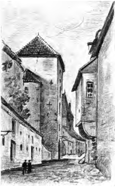
Abb. 118. Ansicht aus der Mauerstraße nahe der ehem. Lehmforte um 1840.
